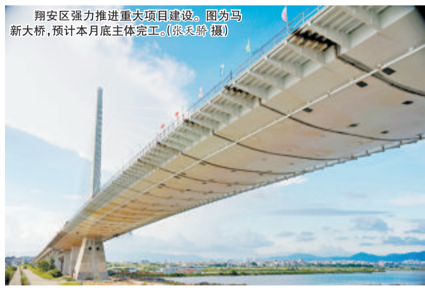
翔安区强力推进重大项目建设。图为马新大桥,预计本月底主体完工。(张奕奕 摄)
